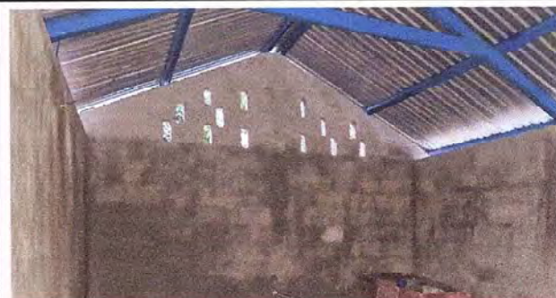
Foto 4: Se observa terminado el repello a las paredes interiores de la cocina.
