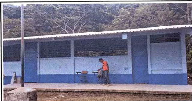
Foto1: Colocada las laminas del techo deteriorado de 3 aulas, bodega y direccion y relleno de agujeros en la pared.
