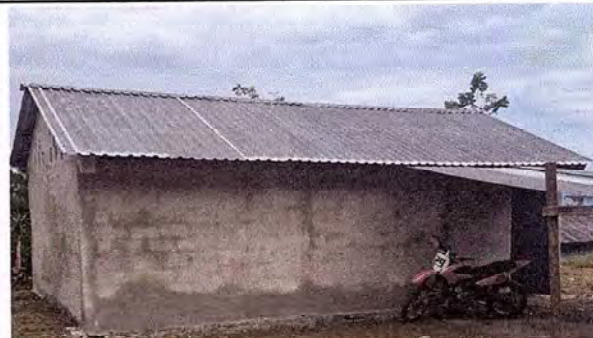
Foto 2: Techo de cocina cambiado, agujeros en las pared rellandos.
